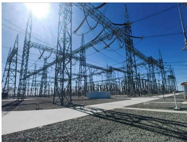
750kV 配电装置区
